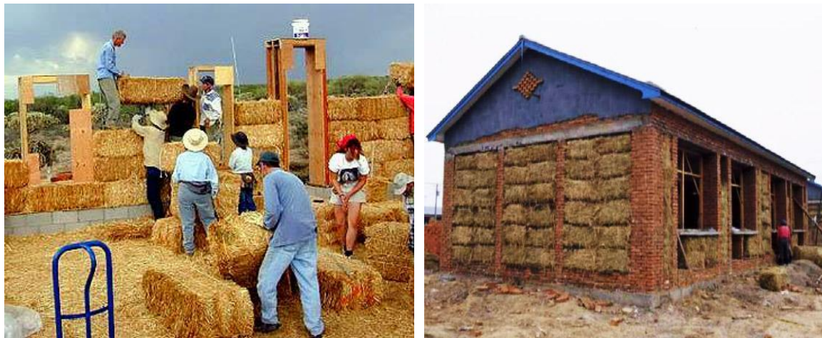
Gambar 3. Pemanfaatan jerami (material alamiah) dalam sebuah bangunan
