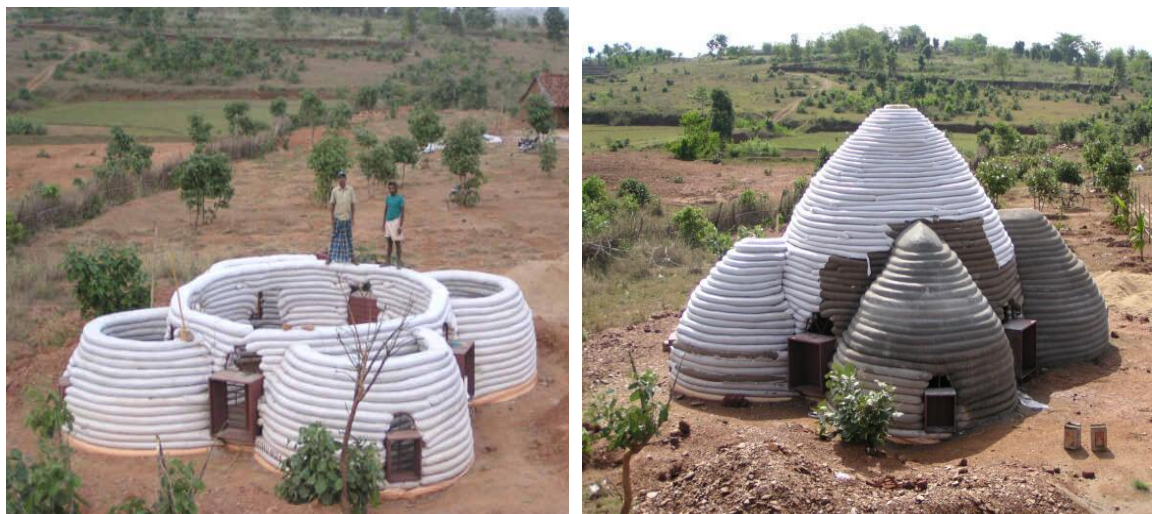
Gambar 1. Pemanfaatan tanah/pasir dalam sebuah bangunan rumah tinggal
