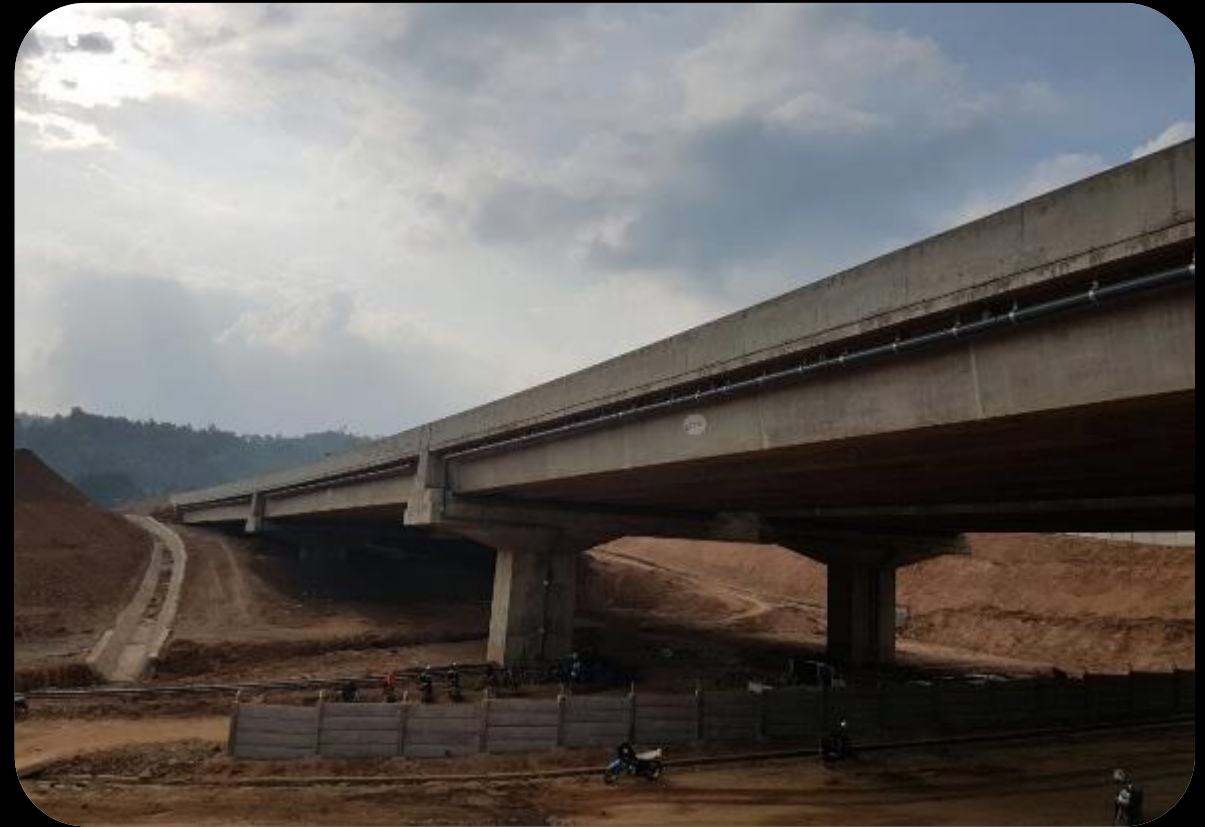
PROYEK TOL CISUMDAWU SUMEDANG- JAWA BARAT
