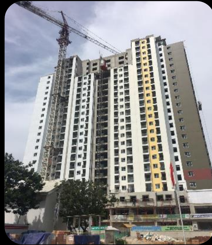
PROYEK WISMA ATLET BLOK D10
