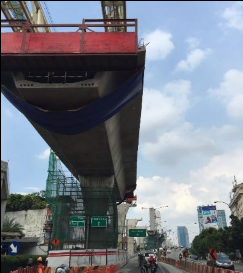
JALAN LAYANG KHUSUS BUSWAY TENDEAN – JAKARTA SELATAN
