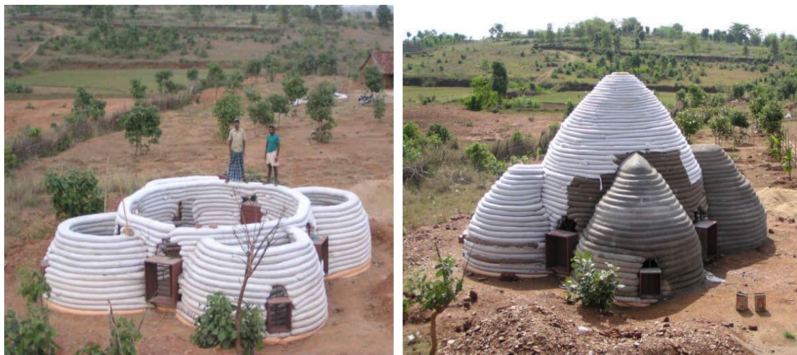
Gambar 1. Pemanfaatan tanah/pasir dalam sebuah bangunan rumah tinggal
