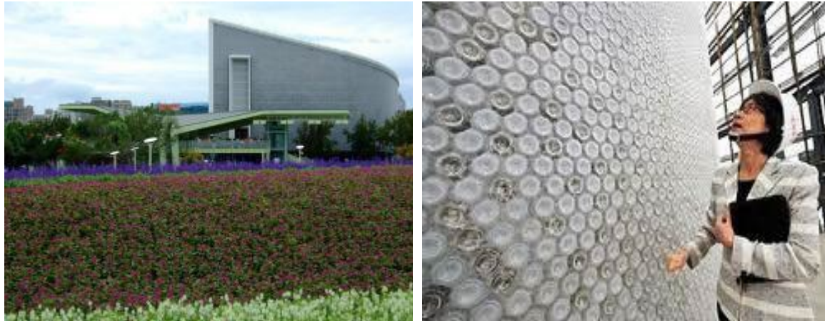
Gambar 6. Pemanfaatan botol plastik daur ulang dalam sebuah gedung pameran di Taiwan
